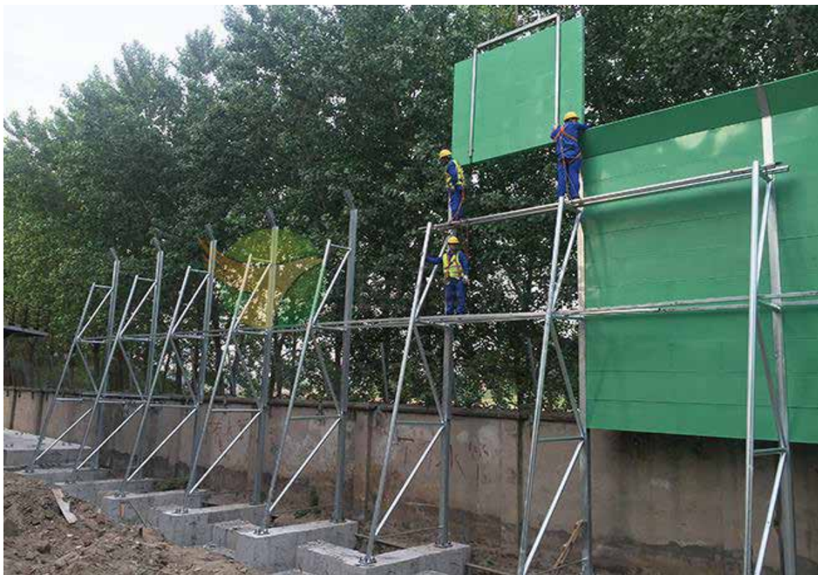
扬州恒润钢铁海洋重工厂界综合降噪工程
