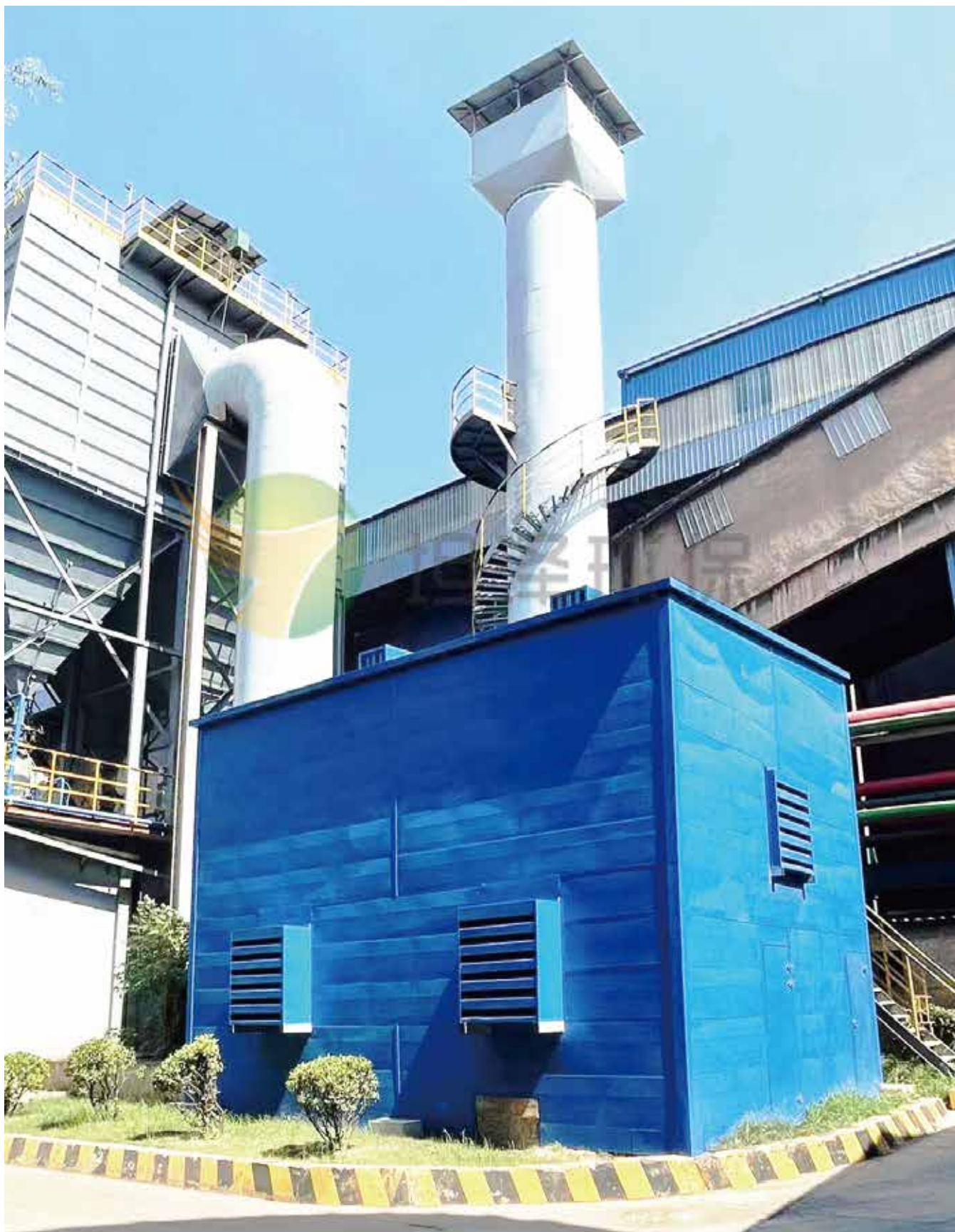
江苏利淮钢铁有限公司烧结厂降噪工厂项目
