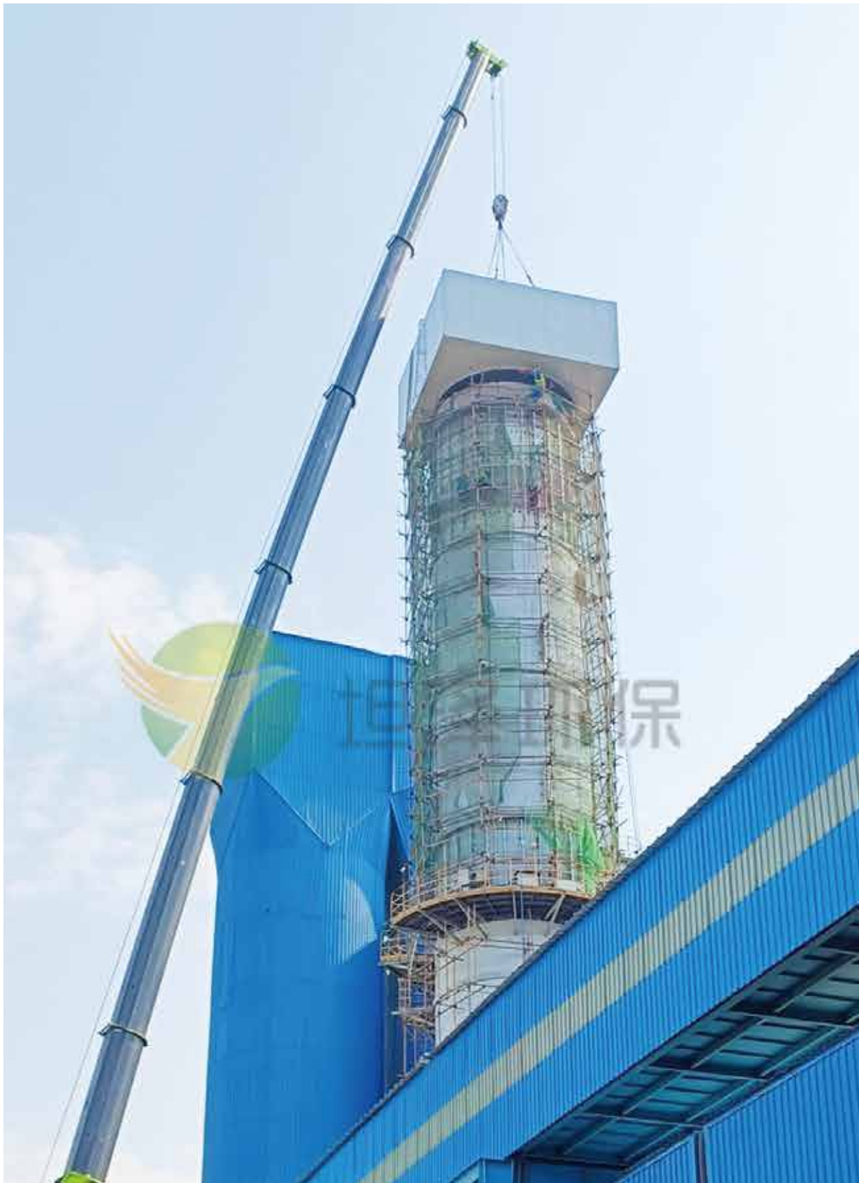
江苏利淮钢铁有限公司烧结厂降噪工厂项目
